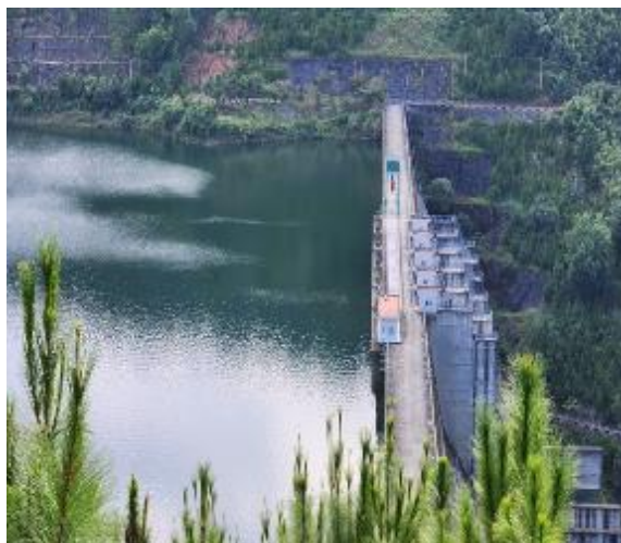
Tuyến đập tràn
